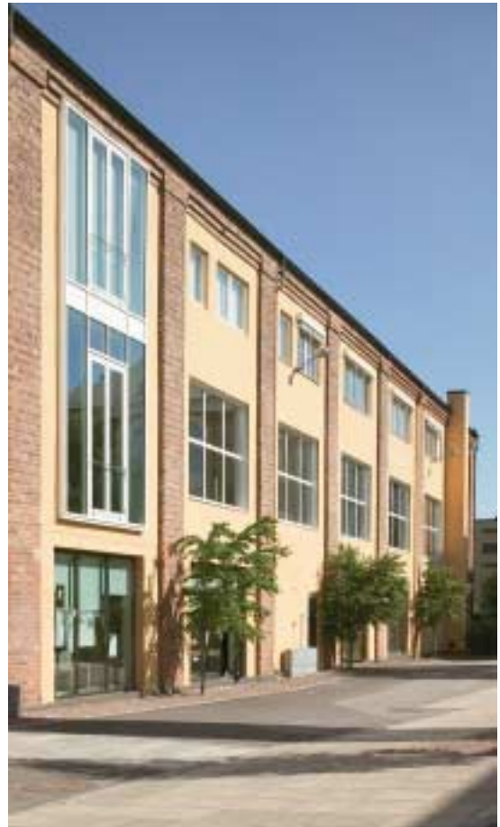
Objekt: Kv. Fønix, Sandefjord, Norge
